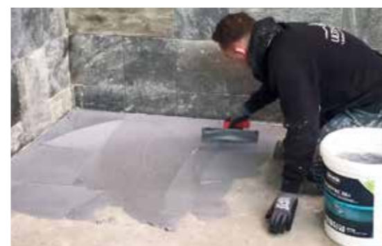
Aanbrengen waterdicht Bostik 2K+ membraan
