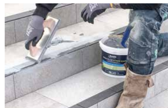
Aanbrengen Agrob Buchtal tegel op de trap van het buitenzwembad
